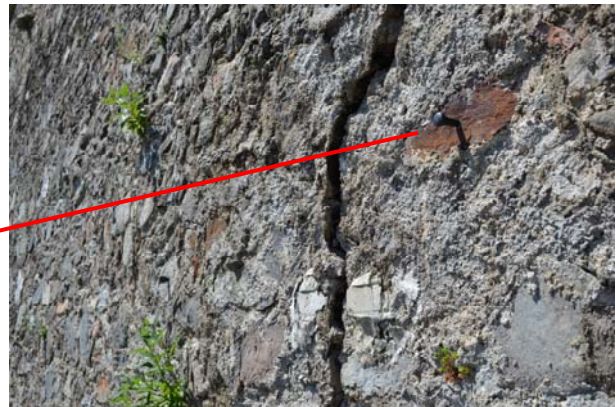
Punto fisso (misurazione Y, X, Z)
