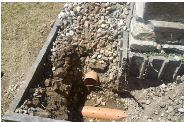
Sondaggio C – drenaggio perimetrale chiesa
