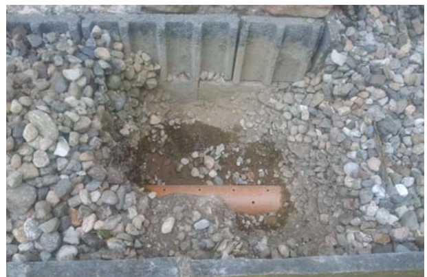
Sondaggio D – drenaggio perimetrale chiesa
