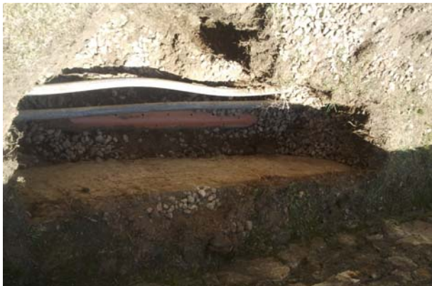
Sondaggio A – rinforzo retromuro esistente
