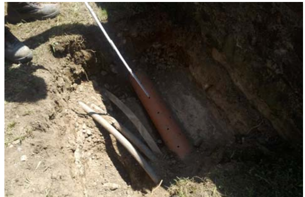
Sondaggio B – mensola retromuro esistente
