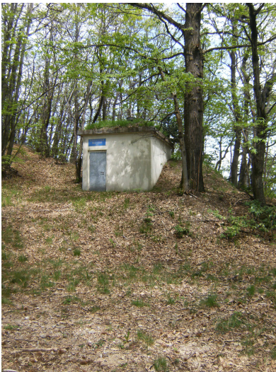
Constatazioni effettuate nell'ambito delle ispezioni
