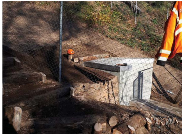
Selciati a protezione del tetto e della zona d'accesso alla sorgente.
