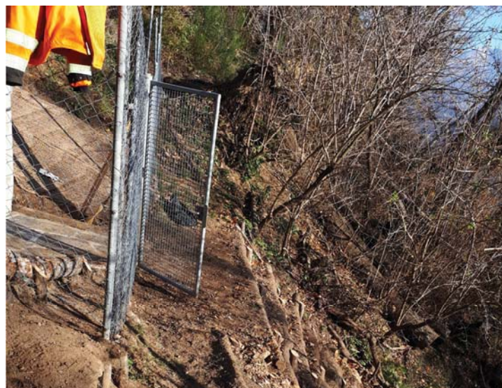
Consolidamento della scarpata nella valletta con tronchi e terra
