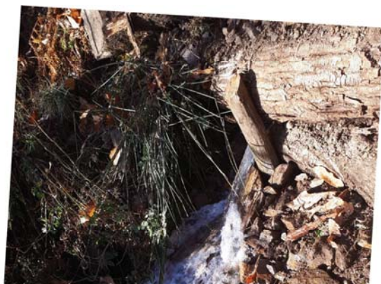
Scarico di fondo nella valletta ai piedi del consolidamento realizzato con tronchi
