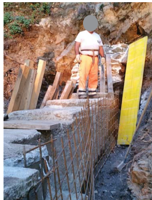
Rete metallica di rinforzo delle pareti del cunicolo
