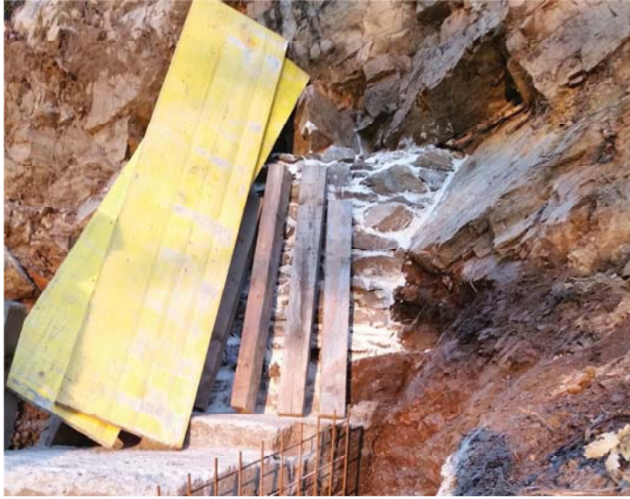
Muro a protezione della scaturigine con sassi e malta speciale.
