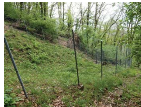
Vista verso valle del cancello e depressione sul manufatto di captazione
