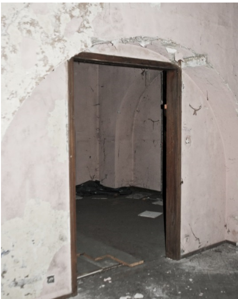
arco tamponato in un salone
