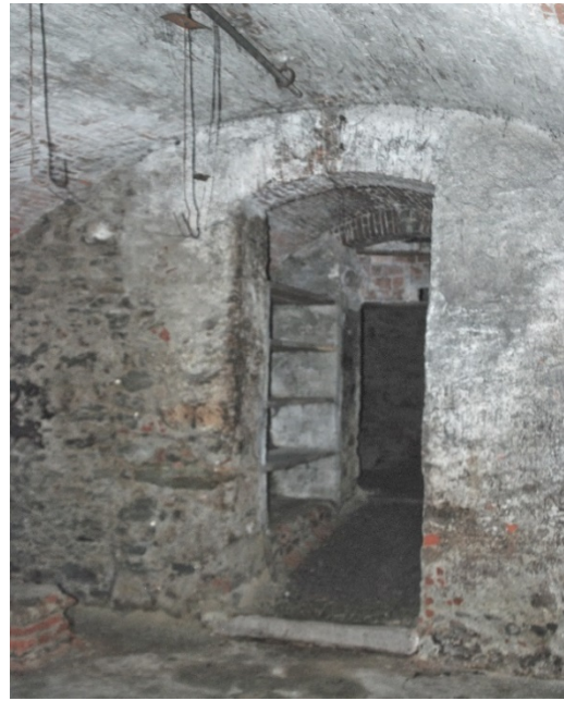
volta di una cantina
