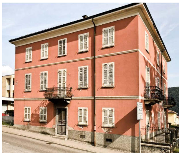
l'edificio visto dalla strada Regina
