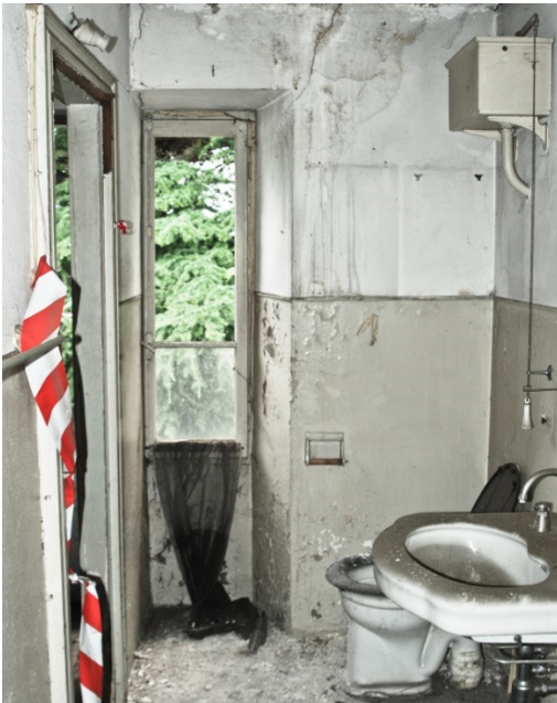
vista di un servizio igienico
