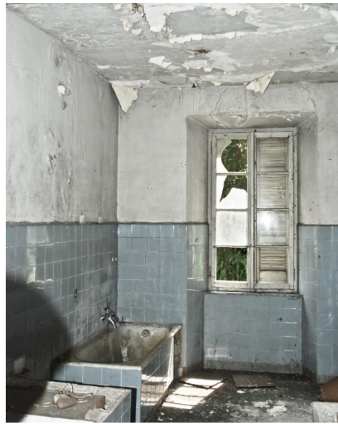
vista di una sala da bagno
