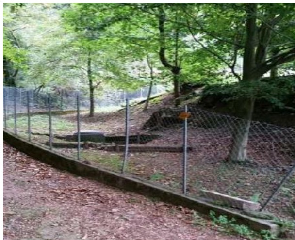
SORGENTE GAGGIO, RECINZIONE E BOTOLA ACCESSO
