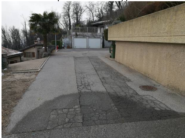
Via Righetto in prossimità del mappale no. 632
