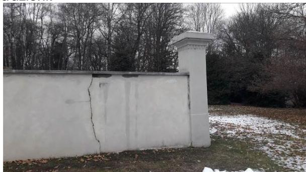
Formazione di muffe con conseguente colorazione scura della superfici, importanti colature dai giunti delle copertine, scrostamenti degli intonaci.
