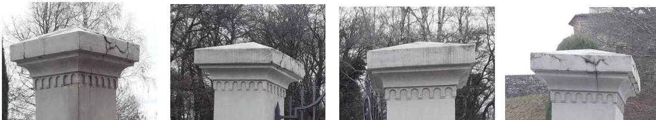
Questo difetto porta ad intaccare strutturalmente anche i pilastri stessi, non più protetti dall'acqua meteorica.
