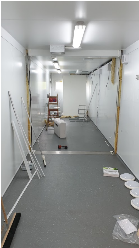
Ristrutturazione bagni – wc bambini (15.06.2020)
