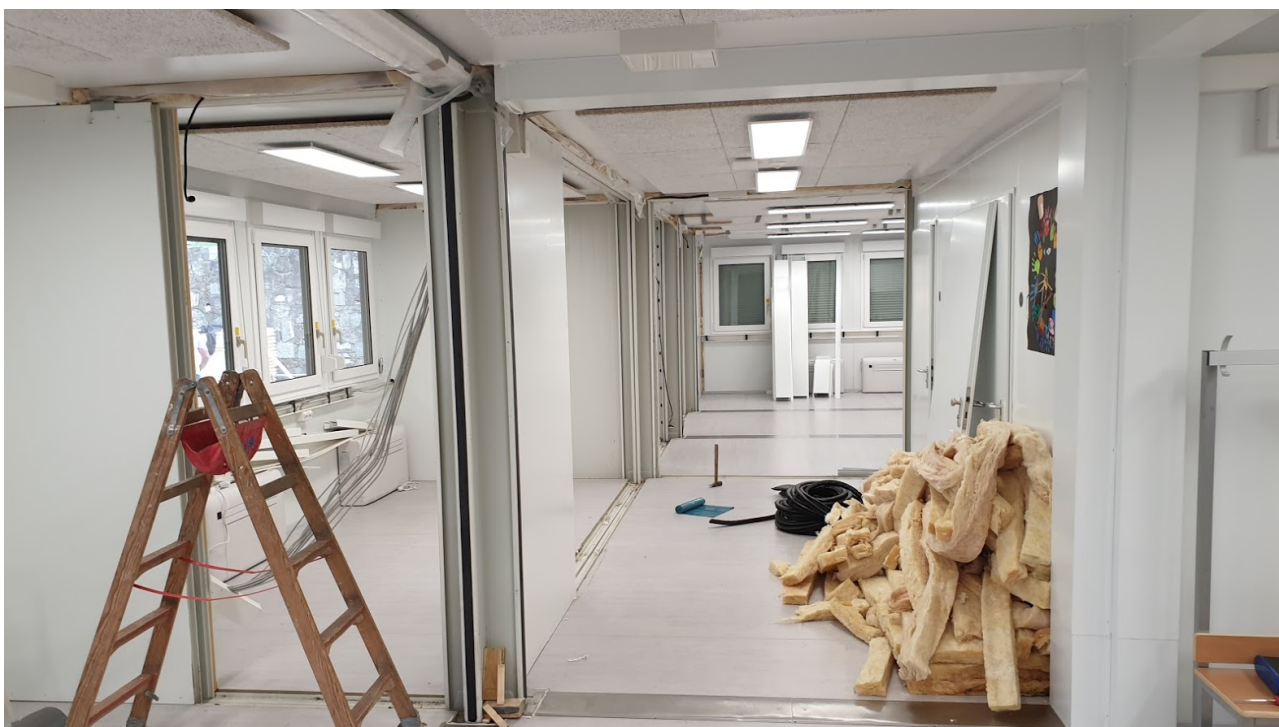
Demolizione zona nuovo atrio – ex uff. direzione, ... aula docenti (19.05.2020)
