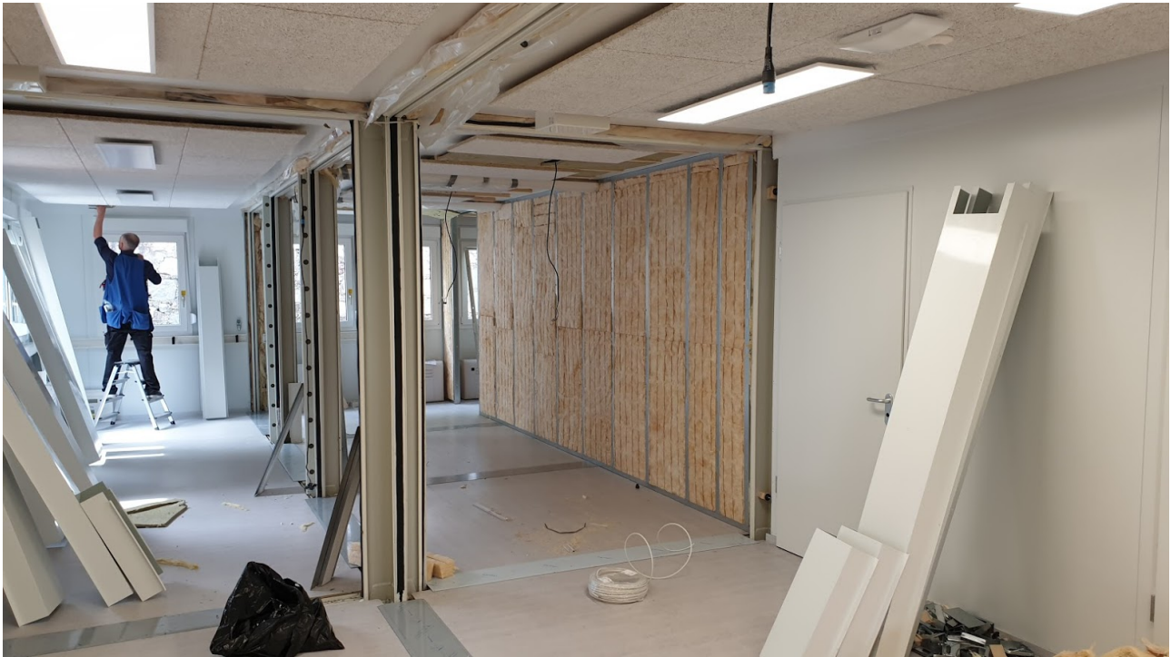
Demolizione zona nuovo atrio – ex uff. direzione, ... aula docenti (26.05.2020)
