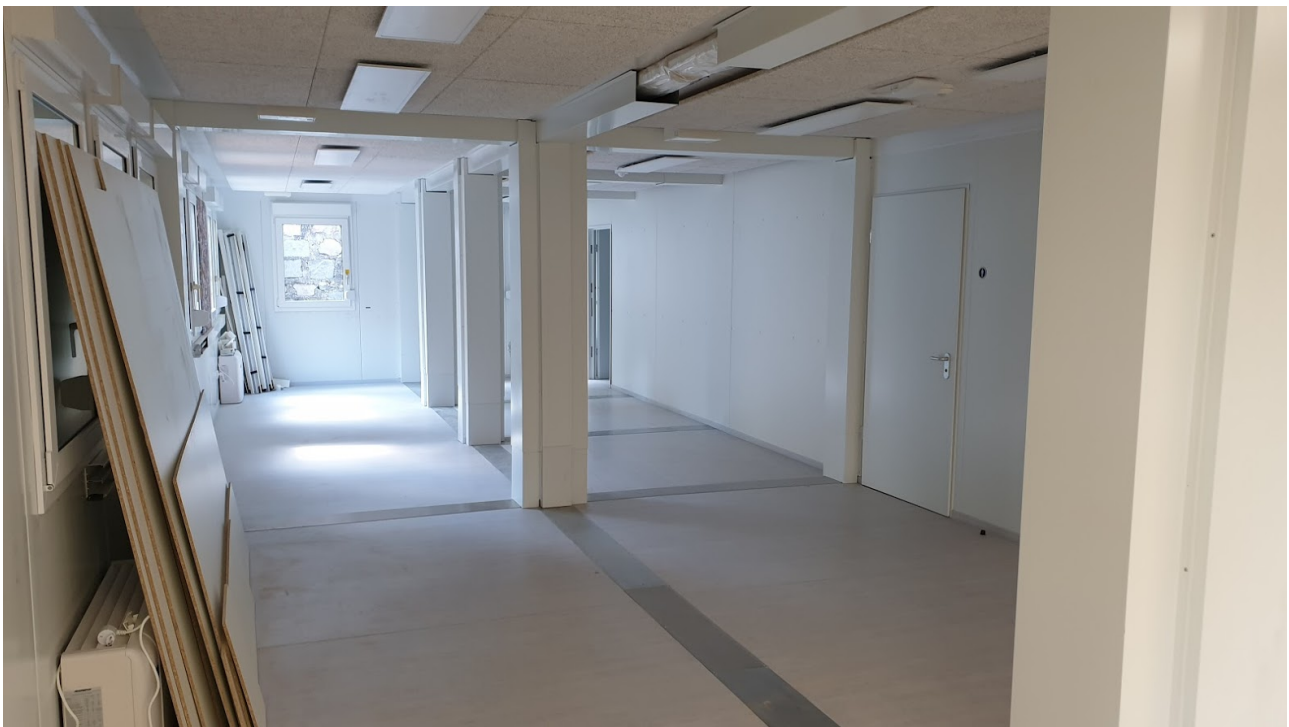
Demolizione zona nuovo atrio – ex uff. direzione, ... aula docenti (29.05.2020)
