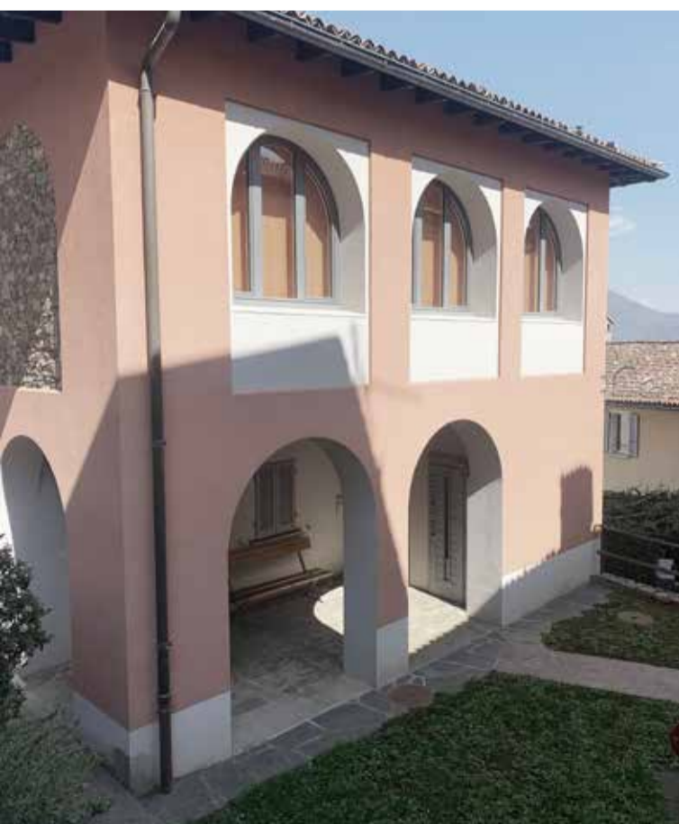
Stabile Ex-cancelleria comunale di Cimo
