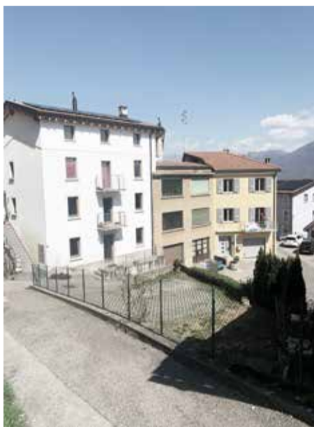
Fronte edificato sulla cantonale
