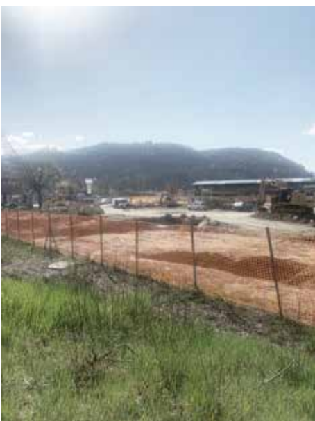
Area in cantiere - nuovo centro Migros
