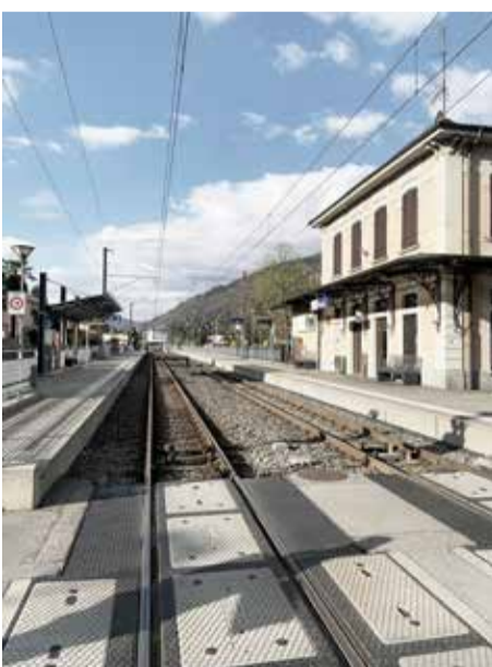
La stazione FLP di Bioggio
