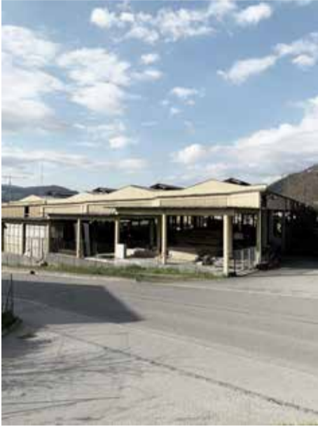
Capannone in via Serta - zona residenziale
