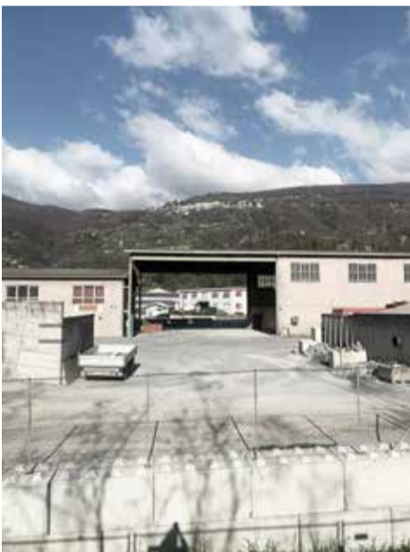
Aree di manovra e stabili industriali
