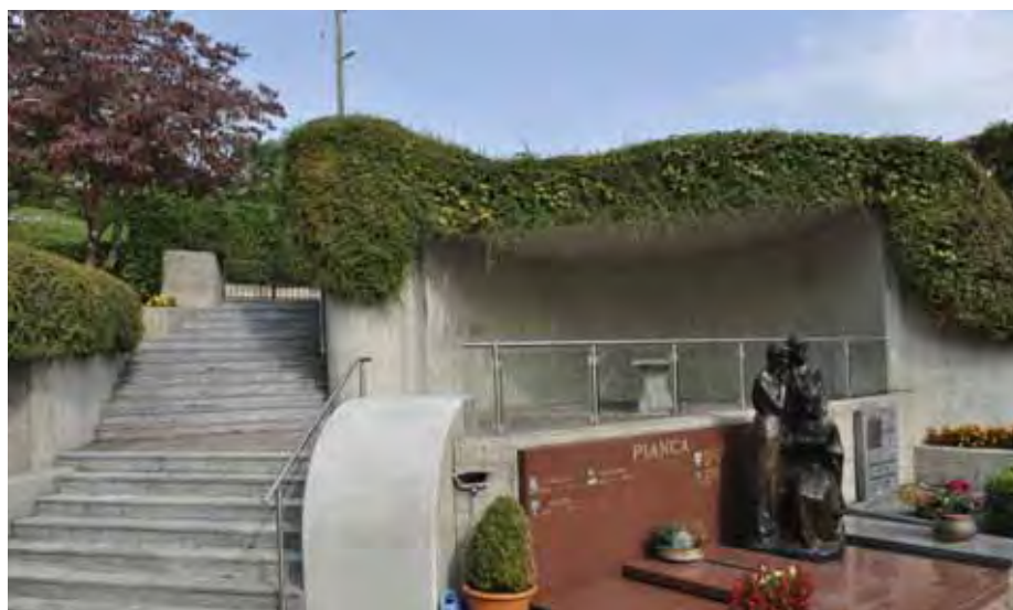
Cimitero di Bosco Luganese: vista dei lavori effettuati all'interno
