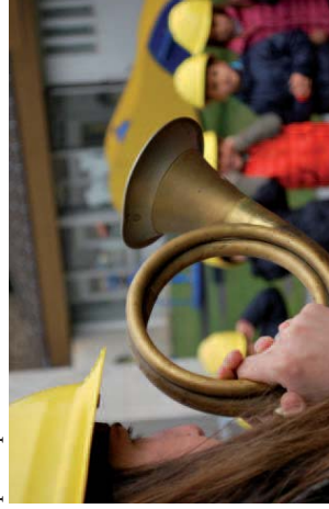
Per prepararsi al brillamento l'addetto emette 5 lunghi suoni seguiti da 5 corti per annunciare l'imminente accensione della miccia. Un unico suono lungo dichiara il via libera allo sgombero.
