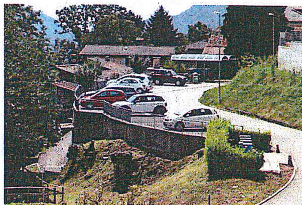
vista generale da nord
